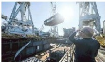
La costruzione I due big: Fincantieri a Sestri Ponente e Mariotti
